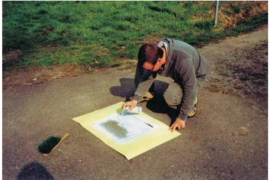
Abb. 2: Der Passpunkt wird mit Farbe markiert
